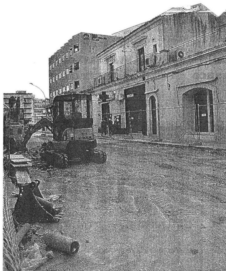
IL CANTIERE SULLA VIA ROMA. A SINISTRA, PIAZZA STAZIONE COM'ERA PRIMA DEI LAVORI
